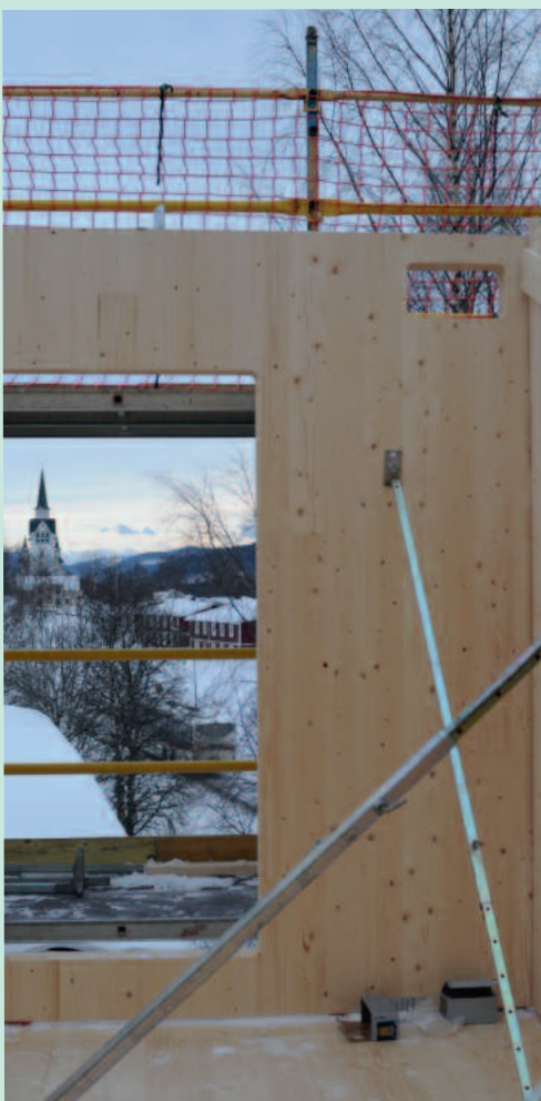
Trästomme med fönsterhåll, projekt Trägården i Duved av AIX arkitekter. Foto: AIX arkitekter
