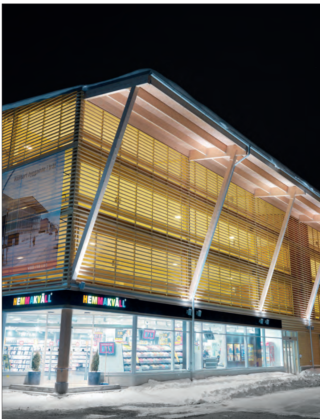
PARKERINGSHUS I TRE. I kystbyen Skellefteå i Norrland i Sverige er det bygget et mindre parkeringshus i tre. Treleverandør er Martinson. Foto: Per Myrehed.
